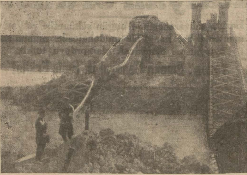
Dirşav'da Vayhzel nehri üzerindeki köprünün hali
